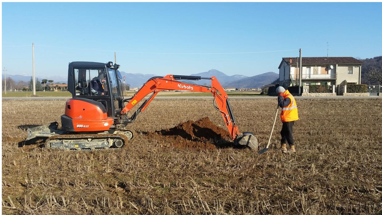
**Fig. 35** – Esecuzione di una trincea realizzata
